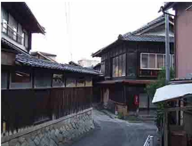
①離れ・⑨石垣及び塀・③旧事務所（西から）
