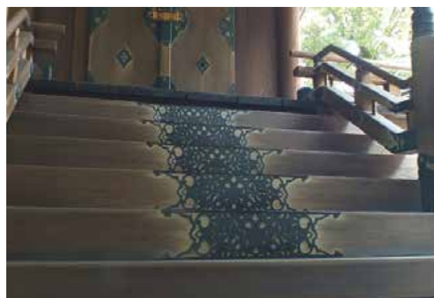
本殿 正面階段飾り金具ほか
