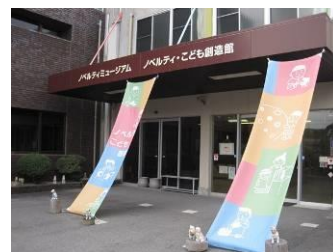
旧大東三進(株)工場 (現ノベルティ・こども創造館)
