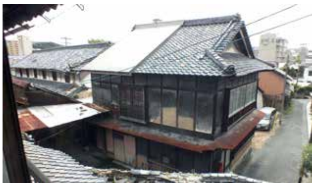
⑤新小屋・③旧事務所（北西から）
