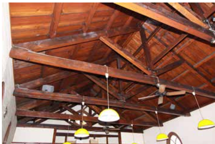
礼拝堂の小屋組（北西より）
