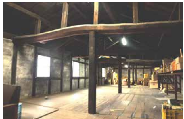
⑤新小屋2階（西から）
