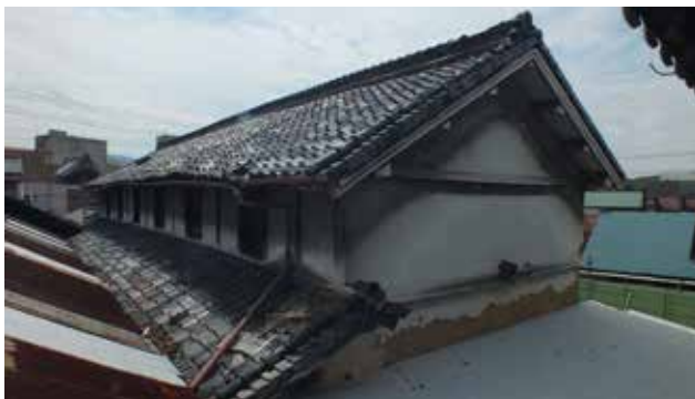
⑤新小屋（北西から）
